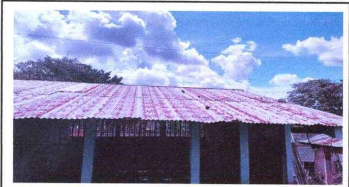
Foto 3: Sustitución de lámina por lámina troquelada calibre 26
