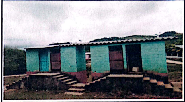
Foto 2: Servicios sanitarios y sus accesorios
