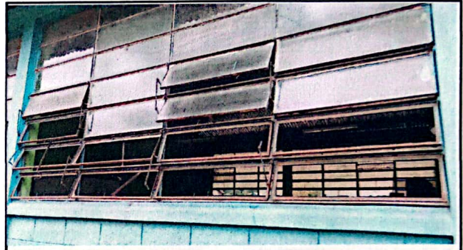
Foto 4: Sustitución de Vidrios
