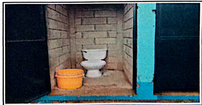
Foto 6: Sustitución de inodoros
