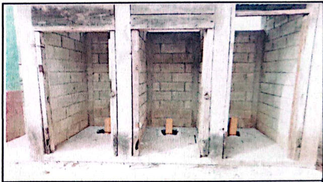
Foto 4: Sustitución de Inodoros
