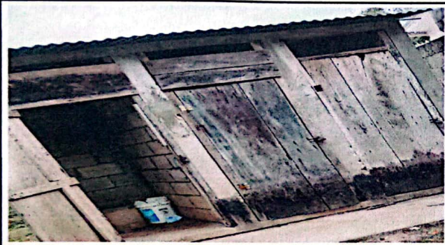
Foto 3: Sustitución de Puertas en baños
