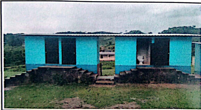
Foto 3: Servicios sanitarios y sus accesorios
