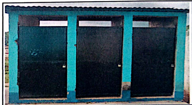
Foto 4: Sustitución de puertas
