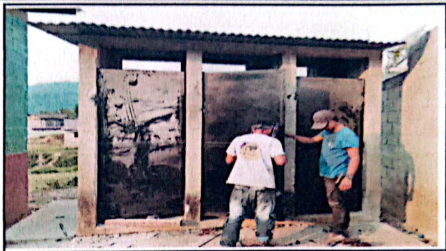
Foto 2: Sustitución de Puertas en Baños
