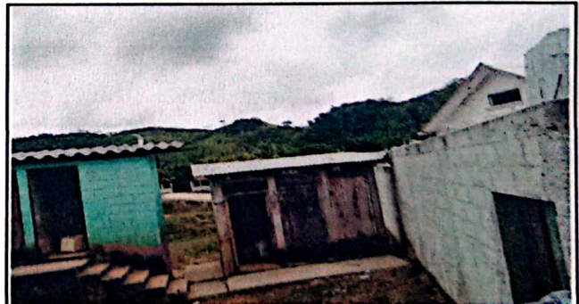
Foto 6: Sustitución de mingitorio
