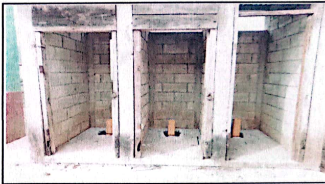
Foto 4: Sustitución de Inodoros
