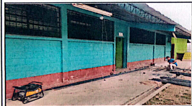
Foto 3: Sustitución de Vidrios por balcones de metal
