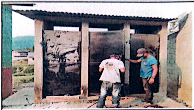
Foto 2: Sustitución de Puertas en Baños
