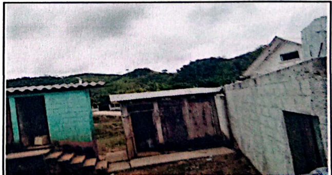
Foto 6: Sustitución de mingitorio
