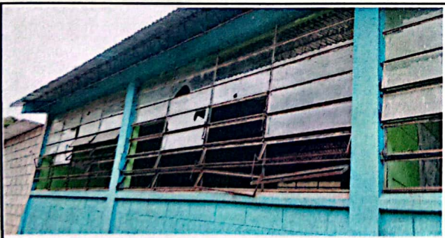
Foto 5: Sustitución de Vidrios en la Parte trasera
