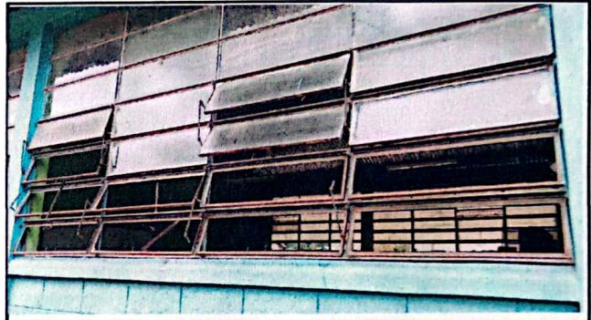
Foto 4: Sustitución de Vidrios
