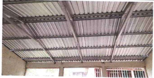
Foto 2: Susticucion de soporte de madera por metal.
