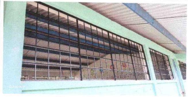
Foto 4: Fabricación e instalación de ventana-balcon de metal.
