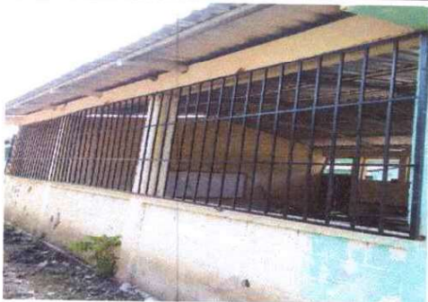
Foto 5: Susticucion de marco de madera y malla por balcones de metal
