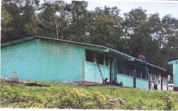
Foto1: Sustitucion de lamina por lamina troquelada
