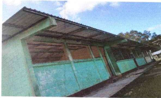
Foto 3: Sustitucion de lamina por lamina troquelada
