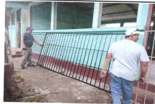
Foto 6: Mantenimiento de balcones de metal.
