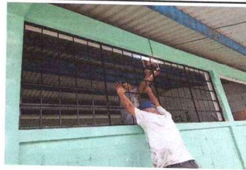
Foto 4: Fabricación e instalación de ventana-balcon de metal.
