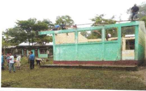
Foto1: Sustitución de lamina por lamina troquelada
