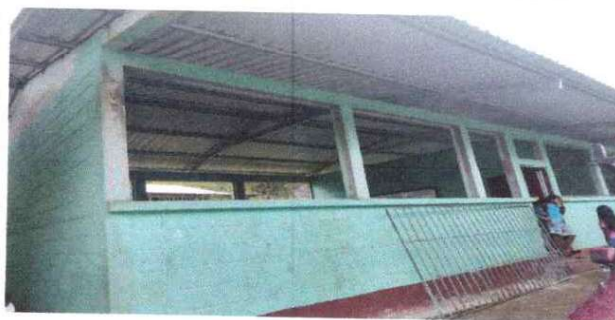
Foto 5: Sustitución de marco de madera y malla por balcones de metal
