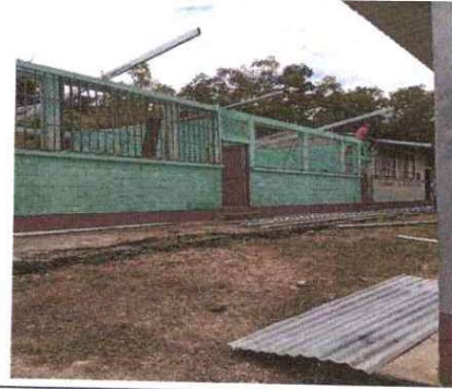
Foto 2: Sustitución de soporte de madera por metal.
