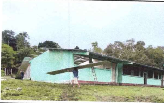
Foto 3: Sustitución de lamina por lamina troquelada
