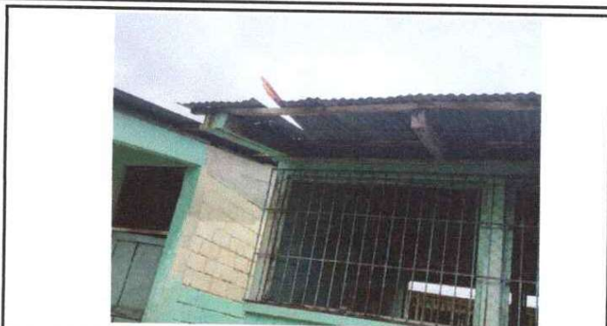
Foto 2: Susticucion de soporte de mader por metal.
