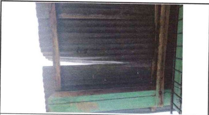
Foto 3: Sustrucion de lamina por lamina troquelada
