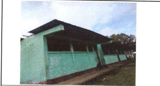
Foto 1: Sustrucion de lamina por lamina troquelada
