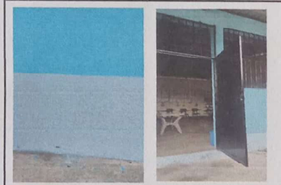
Foto 2. Pintura en muros exteriores e interiores.
