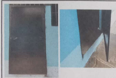
Foto 1. Fabricación e instalación de puertas de metal en módulos
