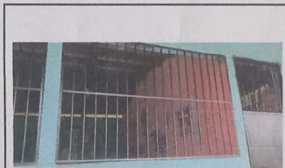
Foto 3. Fabricación e instalación de ventana-balcon de metal
