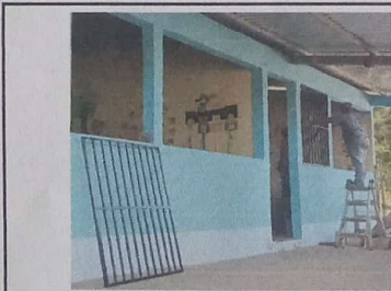
Foto 3. Fabricación e instalación de ventana-balcon de metal
