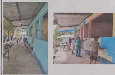
Foto 2. Pintura en muros exteriores e interiores.
