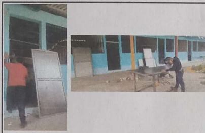
Foto 1. Fabricación e instalación de puertas de metal en módulos
