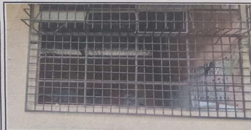
Foto 3. Fabricación e instalación de ventana-balcon de metal
