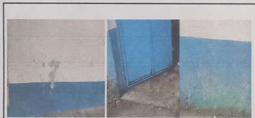
Foto 2. Pintura en muros exteriores e interiores.
