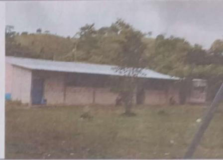
Foto 4: sustitucion de lámina, por lámina troquelada alizinc calibre 28
