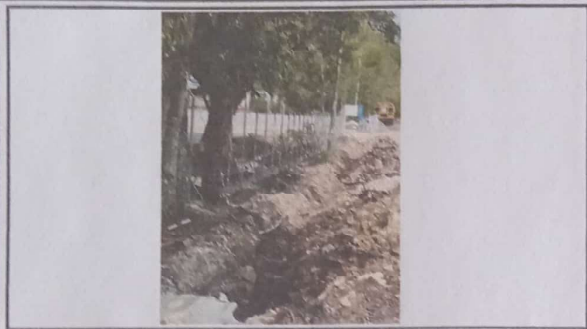
Foto 1: Reparación de Cerco de Alambre de Pua
