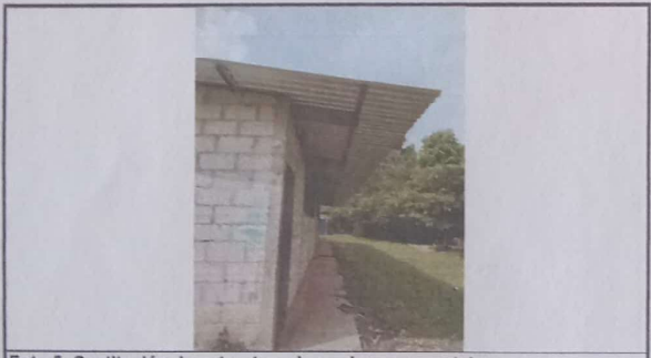
Foto 5: Sustitución de estructura de madera, por metal
