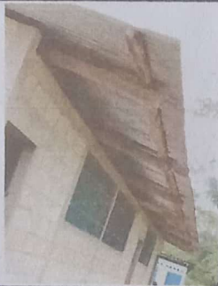
Foto 5: Sustitución de estructura de madera, por metal
