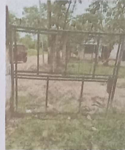
Foto 2: Mantenimiento a un portón de metal
