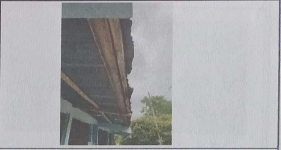
FOTO 6: CAMBIO DE ESTRUCTURA, CORREDOR AULA 2
