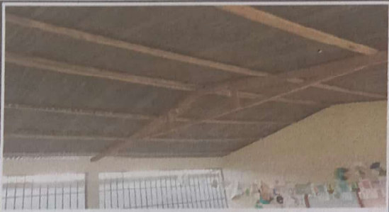
FOTO 3: CAMBIO DE ESTRUCTURA
