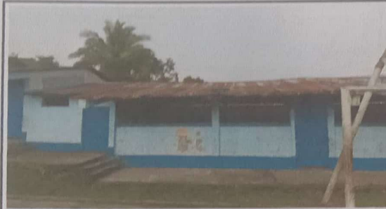
FOTO 1: CAMBIO DE LAMINA
