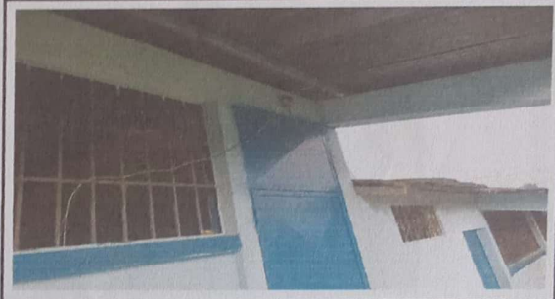
FOTO 4: CAMBIO DE SISTEMA ELECTRICO
