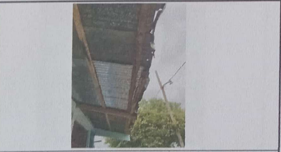
FOTO 5: CAMBIO DE ESTRUCTURA, CORREDOR AULA 1
