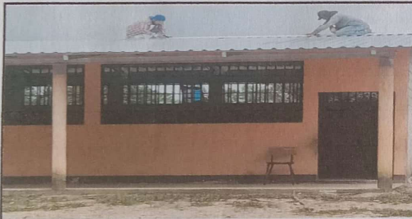
FOTO 4: SUSTITUCION DE ESTRUCTURA PORTANTE
