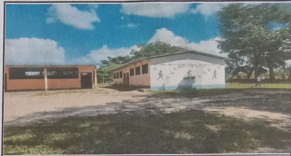
FOTO 2: SUSTITUCION DE ESTRUCTURA DE PORTANTE
