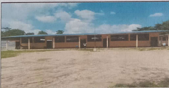
FOTO 5: SUSTITUCION DE LAMINA POR LAMINA ESTRUCTURAL
