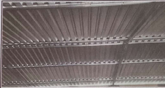
FOTO 5: SUSTITUCION DE LAMINA POR LAMINA ESTRUCTURAL
