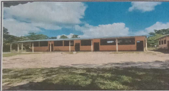
FOTO 1: SUSTITUCION DE ESTRUCTURA PORTANTE
