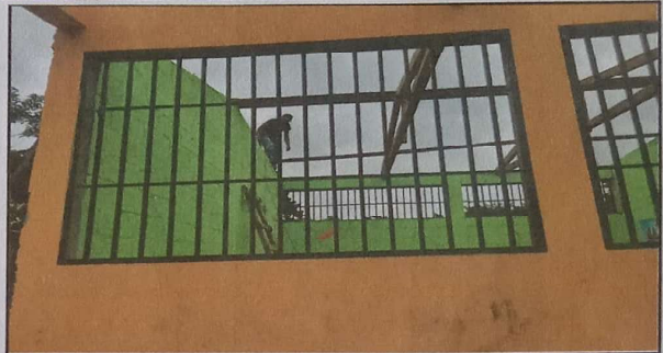
FOTO 2: SUSTITUCION DE ESTRUCTURA DE PORTANTE
