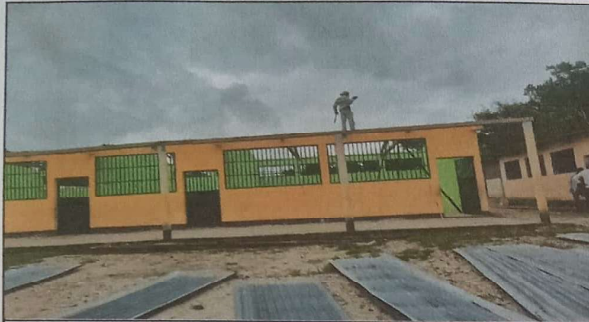
FOTO 1: SUSTITUCION DE ESTRUCTURA PORTANTE
