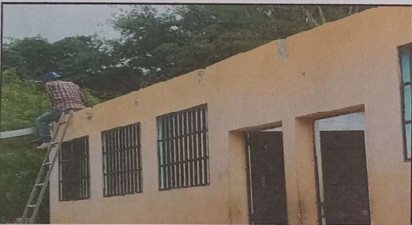
FOTO 4: SUSTITUCION DE ESTRUCTURA PORTANTE
