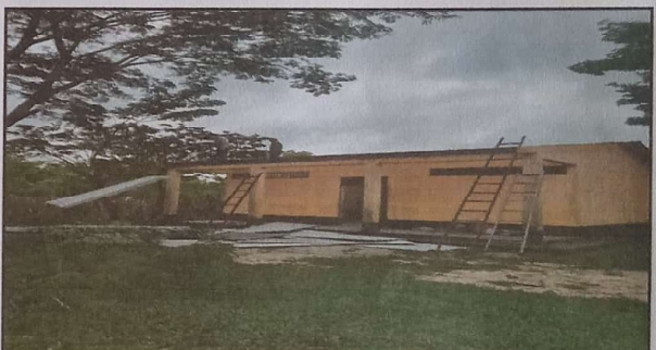
FOTO 5: SUSTITUCION DE LAMINA POR LAMINA ESTRUCTURAL
