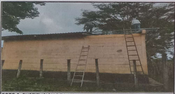
FOTO 5: SUSTITUCION DE LAMINA POR LAMINA ESTRUCTURAL
