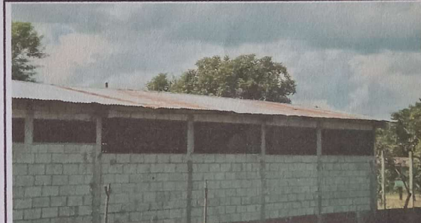
FOTO 5: SUSTITUCION DE LAMINA POR LAMINA ESTRUCTURAL
