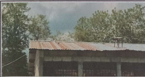
FOTO 5: SUSTITUCION DE LAMINA POR LAMINA ESTRUCTURAL
