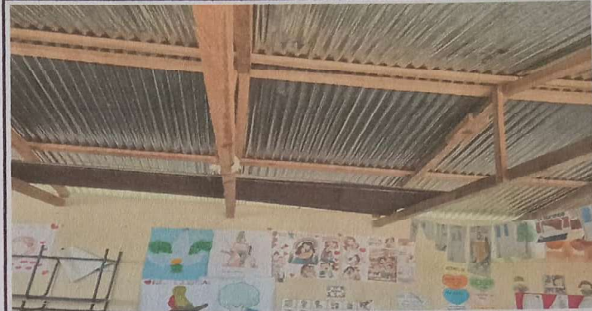
FOTO 2: SUSTITUCION DE ESTRUCTURA DE PORTANTE
