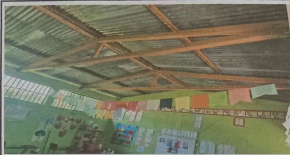
FOTO 1: SUSTITUCION DE ESTRUCTURA PORTANTE
