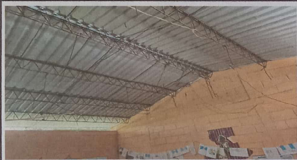
FOTO 4: SUSTITUCION DE ESTRUCTURA PORTANTE
