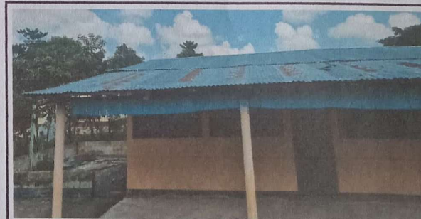
FOTO 6: SISTITUCION DE LAMINA POR LAMINA ESTRUCTURAL
