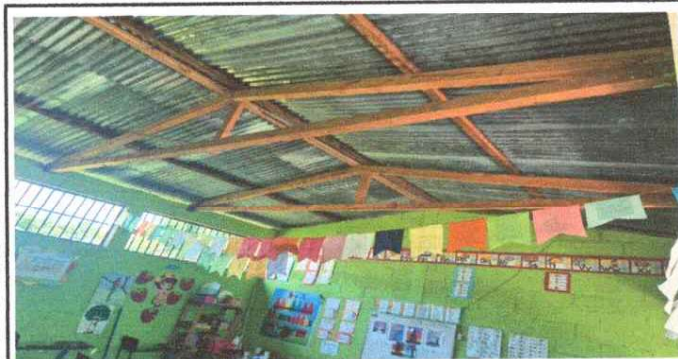
FOTO 1: SUSTITUCION DE ESTRUCTURA PORTANTE
