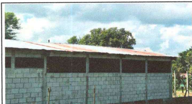
FOTO 5: SUSTITUCION DE LAMINA POR LAMINA ESTRUCTURAL
