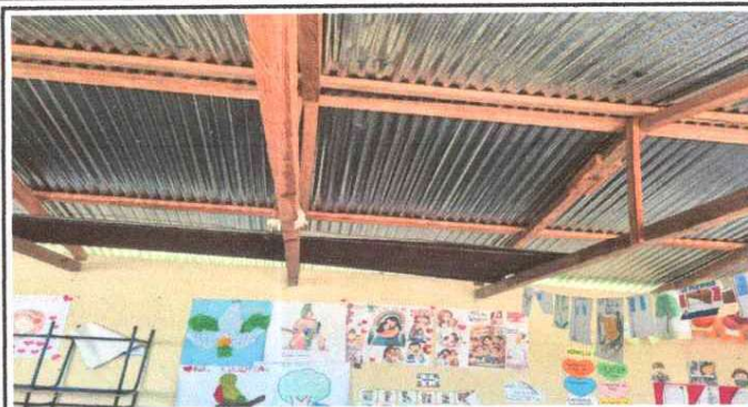
FOTO 2: SUSTITUCION DE ESTRUCTURA DE PORTANTE
