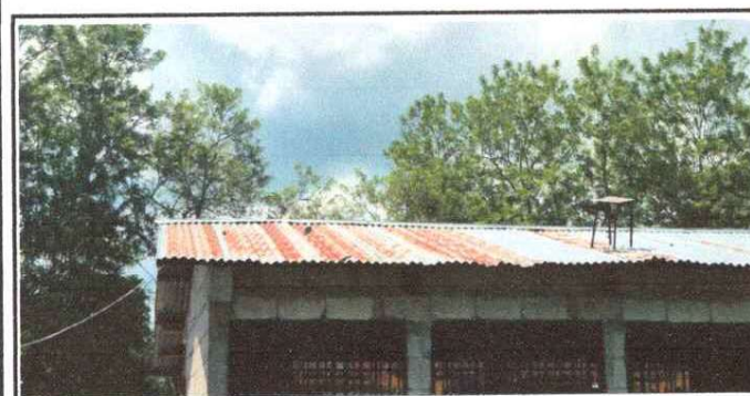
FOTO 5: SUSTITUCION DE LAMINA POR LAMINA ESTRUCTURAL
