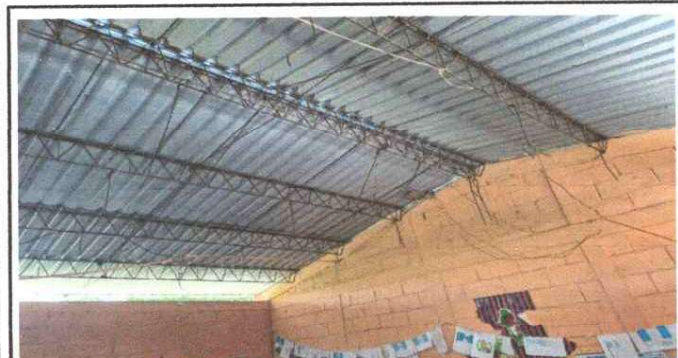
FOTO 4: SUSTITUCION DE ESTRUCTURA PORTANTE
