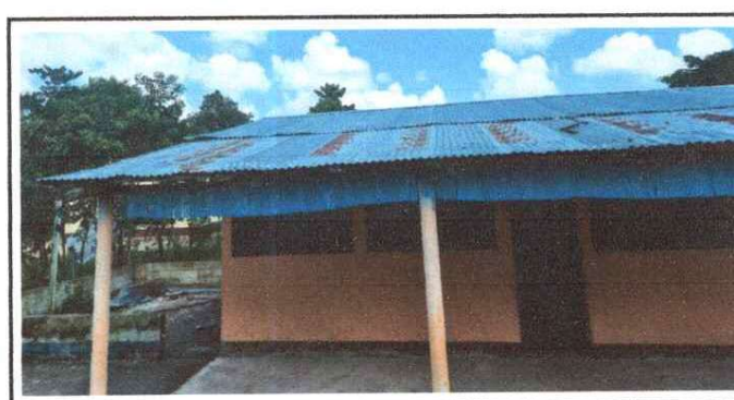
FOTO 6: SISTITUCION DE LAMINA POR LAMINA ESTRUCTURAL
