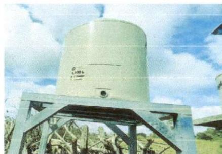
Foto 6: SUSTITUCION DE DEPÓSITO DE AGUA 1100 lt
