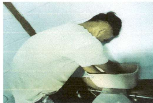
Foto 4: SUSTITUCION DE ACCESORIOS INODORO
