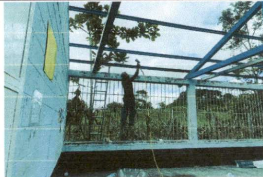
Foto 2: MANTENIMIENTO A ESTRUCTURA DE SOPORTE DE METAL
