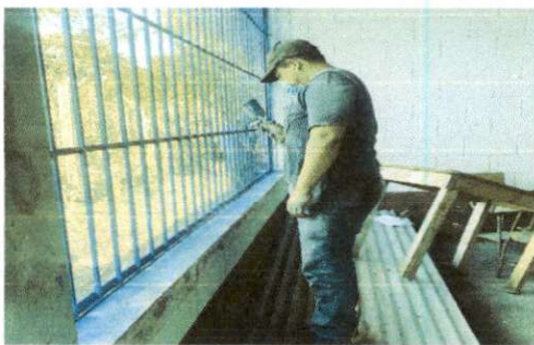
Foto 5: MANTENIMIENTO A BALCONES DE METAL
