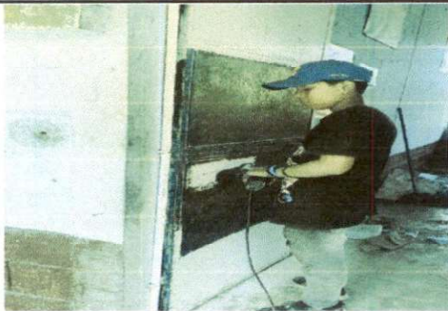
Foto 3: MANTENIMIENTO A PUERTAS DE METAL
