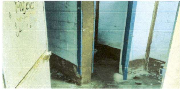
Foto 3: MANTENIMIENTO A PUERTAS DE METAL
