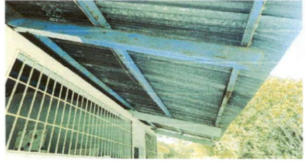
Foto 2: MANTENIMIENTO A ESTRUCTURA DE SOPORTE DE METAL
