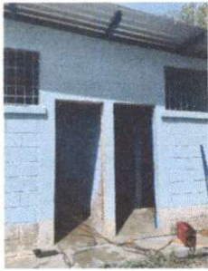
Foto 1: 4.4 Sustitución de puerta en servicios sanitarios
