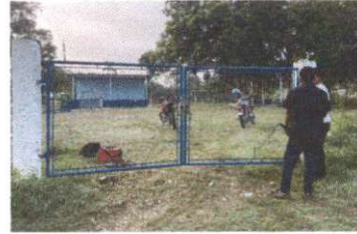
Foto 2: 4.5 Sustitución de portón de metal
