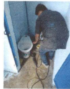
Foto 4: Sustitución de accesorios inodoro (contra llave, tubo de abasto y tanque) y 10.5 Sustitución lavamanos
