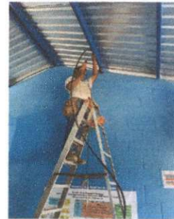
Foto 2: 17.11 Reparación de cableado eléctrico, 17.12 Sustitución de ducto eléctrico + accesorios y 17.1 Sustitución de tablero de flipones.
