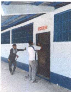
Foto 5: 4.1 Mantenimiento a estructura (lijado, cambio de tubo, cepillado, sujeciones, aplicación de pintura)
