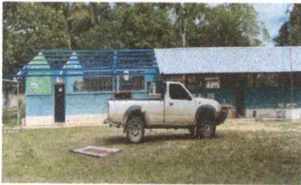
Foto 3: 1.1 Sustitución de lámina, por lámina troquelada aluzinc calibre 26, 1.2 Sustitución de capote de lámina para lámina troquelada y 1.3 Sustitución de elementos de fijación.
