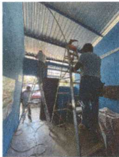
Foto 3: 17.4 Sustitución de focos ahorradores y 17.5 Sustitución de plafoneras
