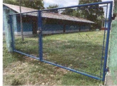
Foto 2: 4.5 Sustitución de portón de metal
