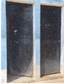
Foto 1: 4.4 Sustitución de puerta en servicios sanitarios
