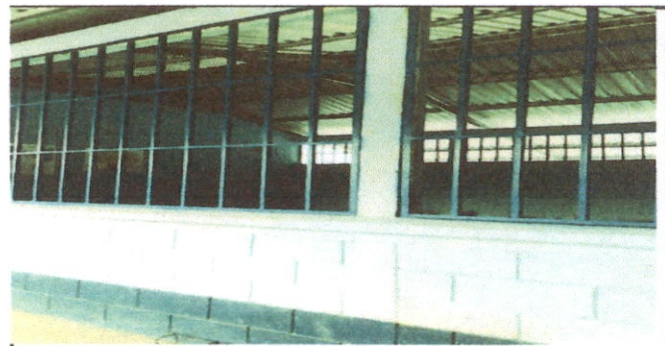
Foto 4: VISTA DE ENFRENTA DE LOS VENTANALES
