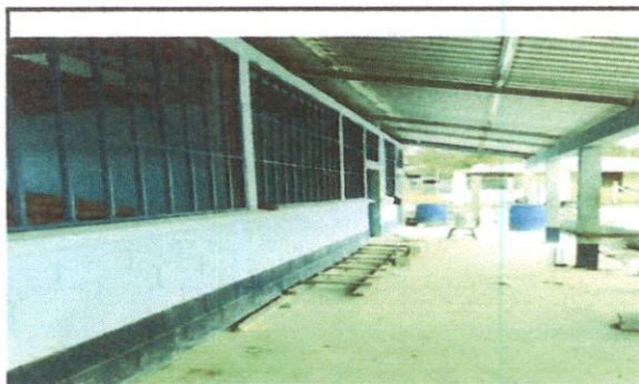
Foto 3: FINALIZADO EL BALCONEADO
