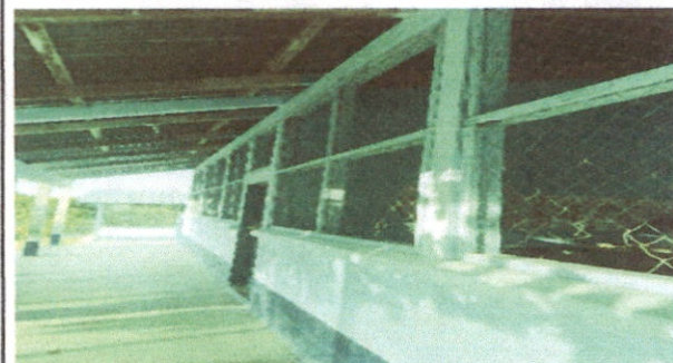
Foto 6: se remozarán las dos aulas y dirección
