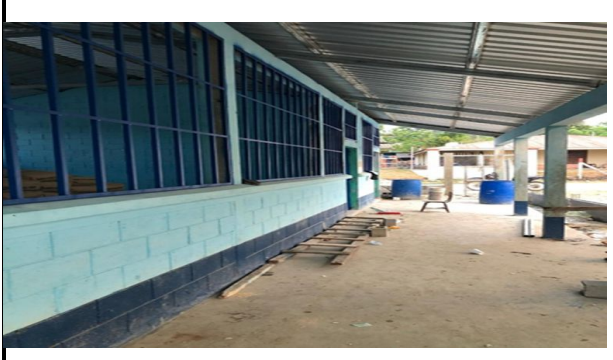
Foto 3: FINALIZADO EL BalcONEADO
