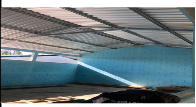
Foto 2: PARTE INTERNA DE UNA DE LAS AULAS FINALIZADA
