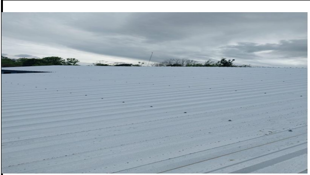
Foto1: FINALIZADO EL TECHO
