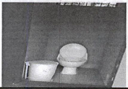
FOTO 11. SUSTITUCION DE PISO CERAMICO
