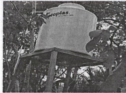
Foto 10. Renglón 18.1 Sustitución de depósito de agua de 1100 litros
