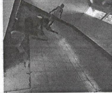
Foto 2: Instalación de piso cerámico en aulas, dirección y sanitarios
