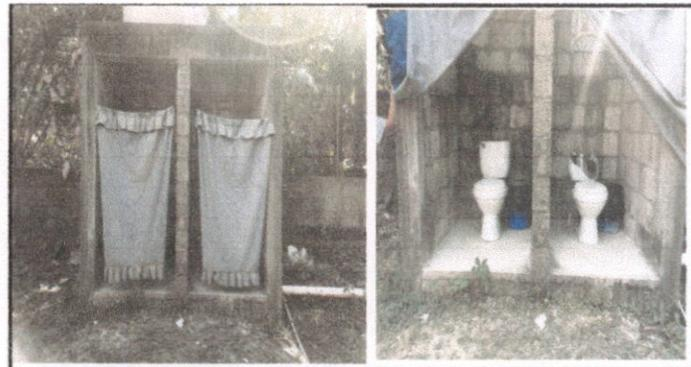
Foto 6: Vista general del estado en que se encuentran los baños de la escuelita, con cortina y baños en mal estado y sin conexión a caño de agua.
