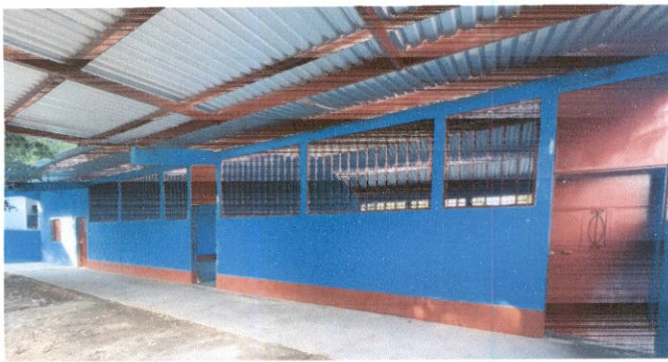
Foto1: sustitucion de estructura de techo
