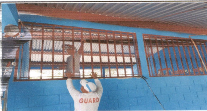
Foto 3: Colocacion de ventana
