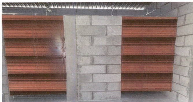
Foto 5: Colocacion de Puertas de Banos
