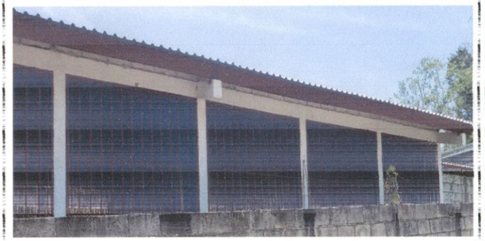
Foto 6: Sustitucion y Colocacion de balcon con mailla
