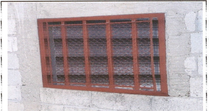
Foto 4: Sustitucion de Estructura
