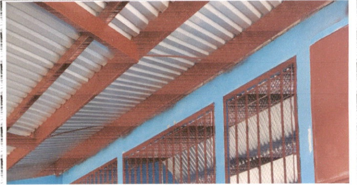
Foto 2: Sustitucion de Lamina por lamina
