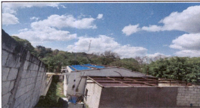
PINTURA EN ESTRUCTURA DE TECHO
