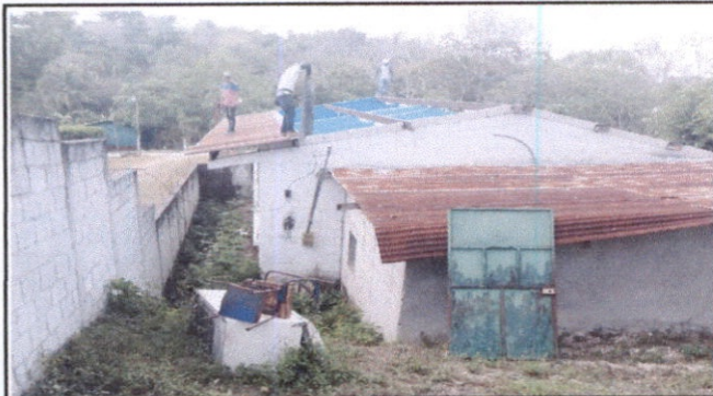
SUSTITUCION DE LAMINA DE TECHO
