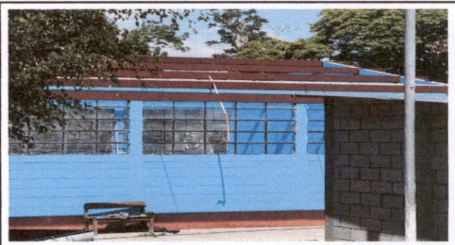
REPARACION Y MANTENIMIENTO DE ESTRUCTURA DE TECHO
