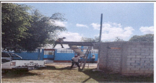
COLOCACION DE LAMINA GALVANIZADA
