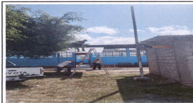
COLOCACION DE LAMINA GALVANIZADA
