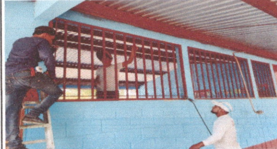
Foto 2: Sustitucion de Lamina por lamina
