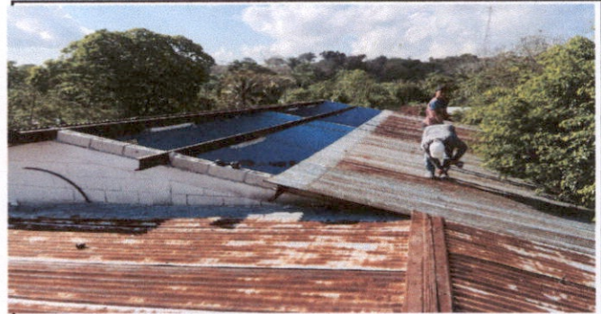
SUSTITUCION DE LAMINA DE TECHO
