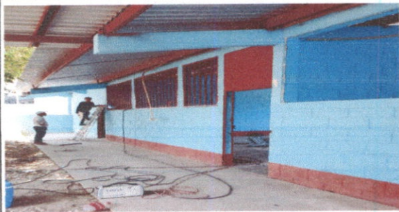
Foto 1: sustitucion de estructura de techo
