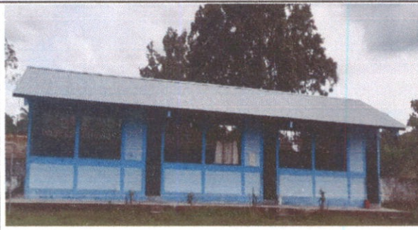
Foto 3: Sustitución de lámina, por lámina troquelada aluzinc calibre 26.
