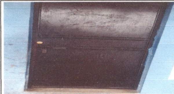
Foto 4: Sustitución de chapa.
