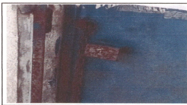
Foto 4: Sustitución de chapa.
