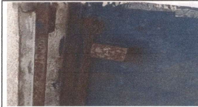
Foto 4: Sustitución de chapa.
