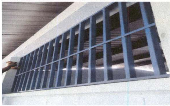
Foto 3: Fabricación e instalación de balcones de hierro en ventana.
