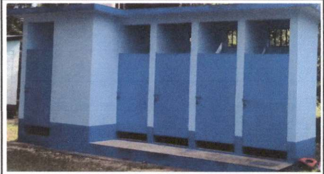
Foto 4: Mantenimiento e estructura de puertas de metal.
