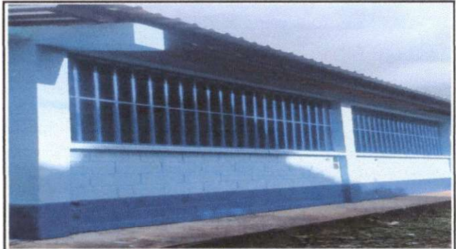
Foto 2: Sustitución de balcones de metal.
