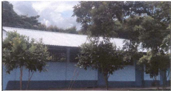
Foto 6: Pintura de muros de interiores y exteriores.
