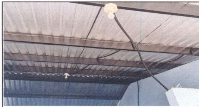
Foto 5: Instalación de unidades de luz yde fuerza.
