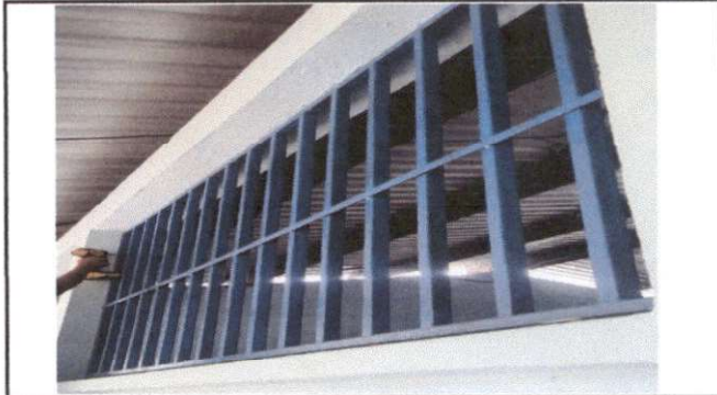
Foto 2: Sustitución de balcones de metal.
