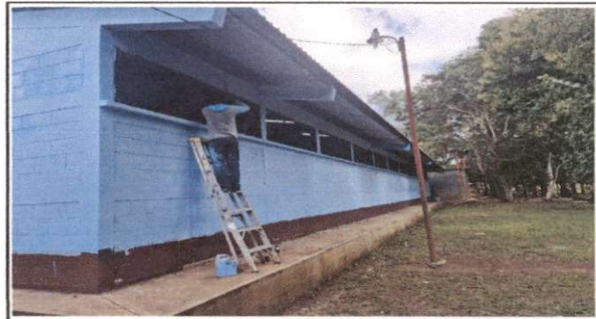
Foto 6: Pintura de muros de interiores y exteriores.
