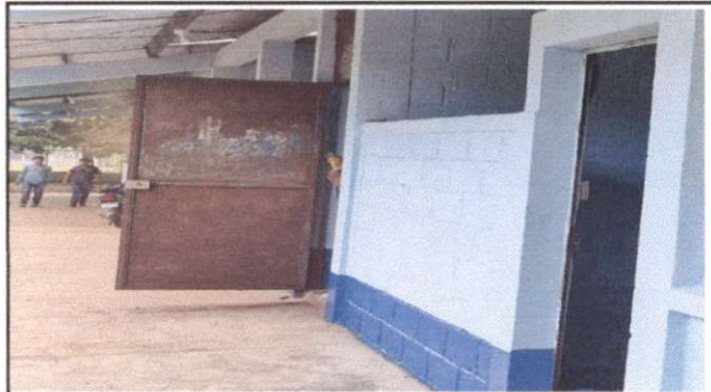
Foto 4: Mantenimiento e estructura de puertas de metal
