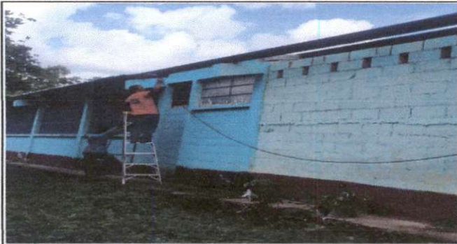
Foto 5: Instalación de unidades de luz yde fuerza.
