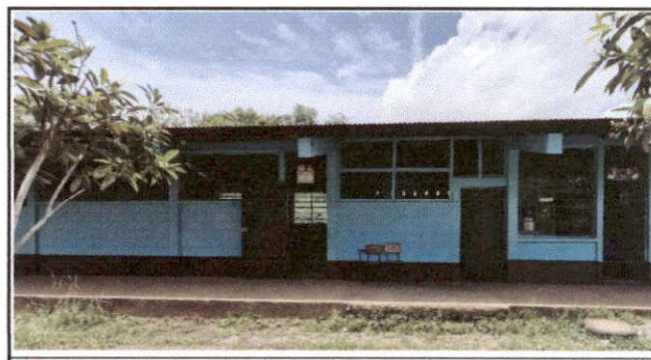
Foto 6: Pintura de muros de interiores y exteriores.
