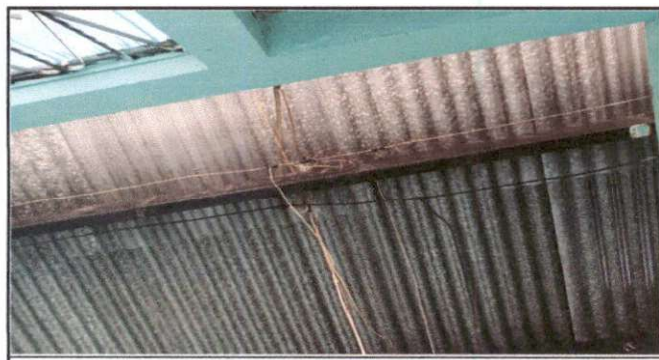
Foto 5: Instalación de unidades de luz y de fuerza.
