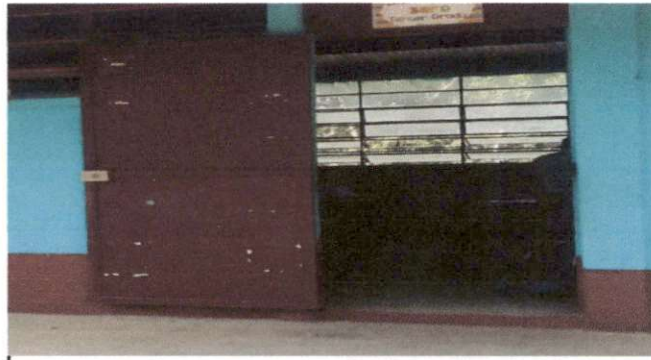
Foto 4: Mantenimiento e estructura de puertas de metal
