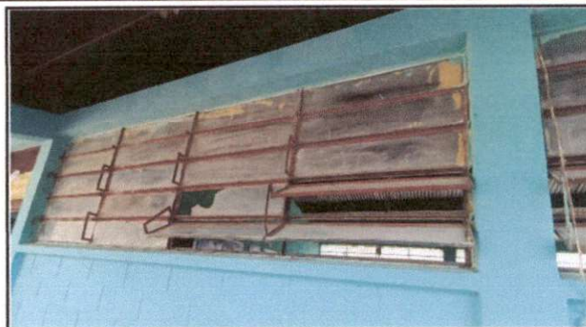
Foto 2: Sustitución de balcones de metal.
