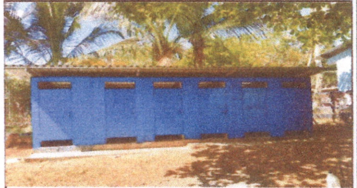
Foto 2: Finalización de cubierta de lámina y puertas en el área de baños.
