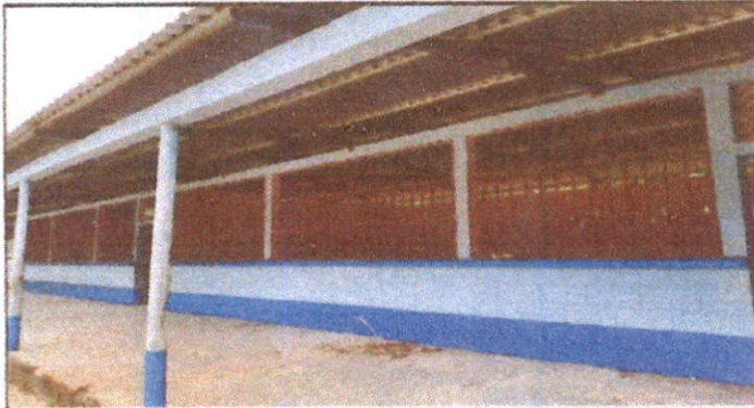
Foto 1: Finalización de cubierta de lámina en aulas, biblioteca y bodega.
