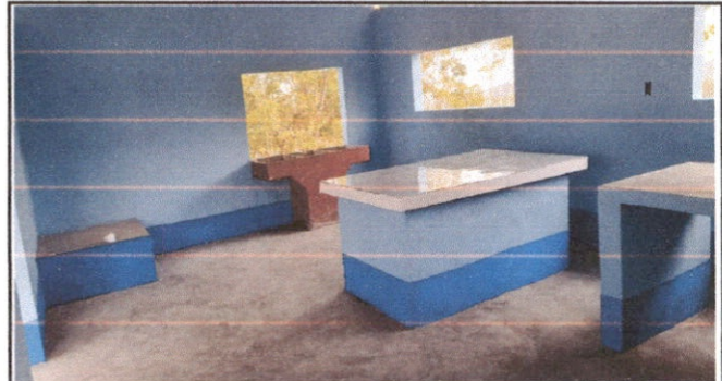
Foto 4: Instalación de pila en cocina.
