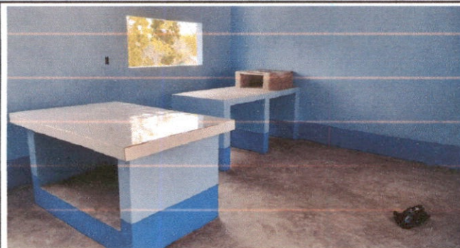
Foto 3: Instalación de azulejo en mesa de concreto.
