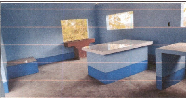
Foto 5: Piso torta de cemento liso.
