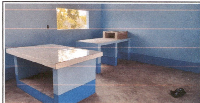
Foto 6: Piso torta de cemento liso.
