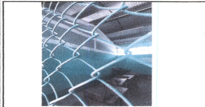
Foto 3: Renglon No 5.6 Sustitución de balcones de metal.
