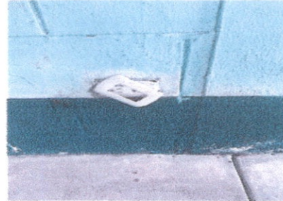
Foto 8: renglon 17.8 Sustitución tomacorrientes dobles
