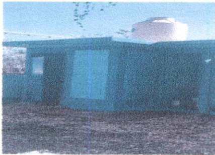
Foto 8: Sustitución de accesorios depósito de agua.
