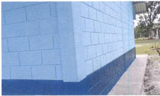
Foto 3: Pintura en muros exteriores e interiores
