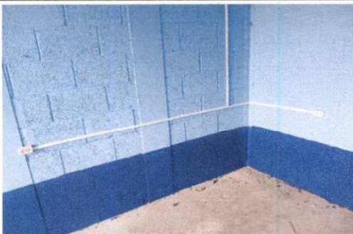
Foto 5: Sustrucción de tomacorrientes dobles
