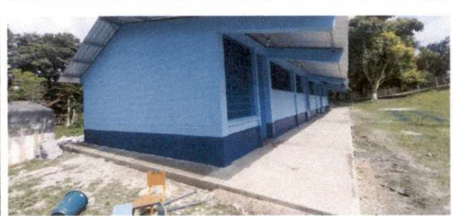
Foto 2: Sustrucción de piso de torta de cemento
