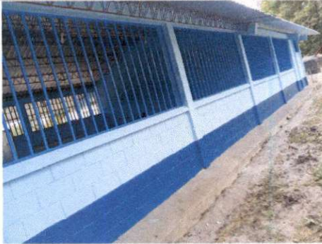
Foto 1: Sustrucción de estructura de metal de ventana
