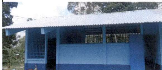
Foto 6: Sustrucción de lámina, por lámina troquelada aluzinc calibre 26
