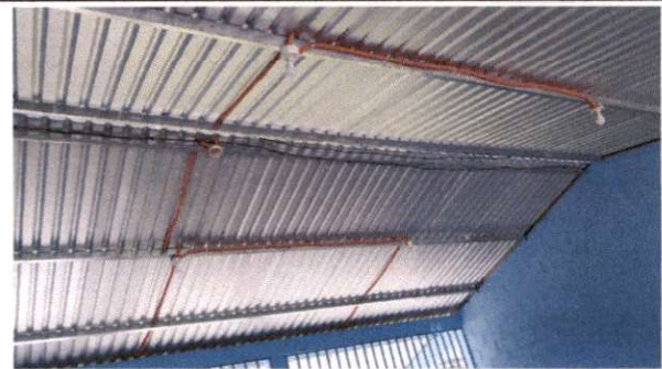
Foto 4: Reparación de cableado eléctrico
