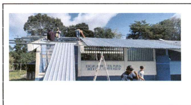
Foto 6: Sustitución de lámina, por lámina troquelada aluzinc calibre 26
