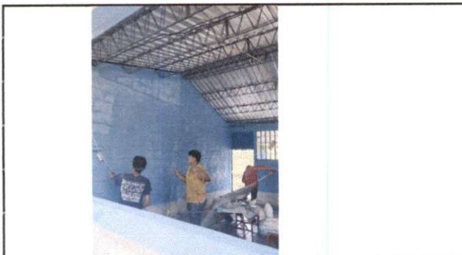
Foto 3: Pintura en muros exteriores e interiores
