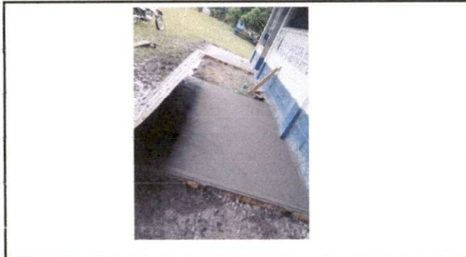
Foto 2: Sustitución de piso de torta de cemento
