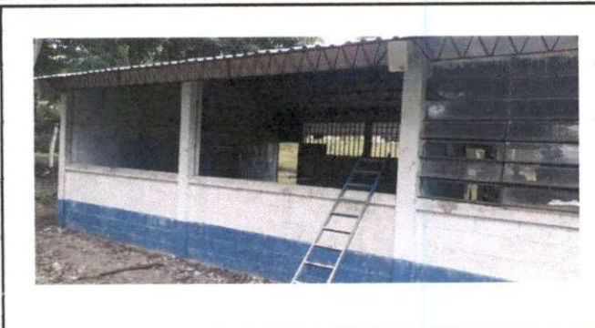
Foto1: Sustitución de estructura de metal de ventana
