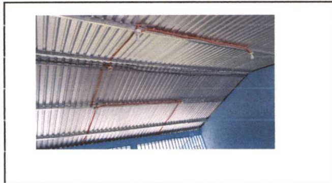
Foto 4: Reparación de cableado eléctrico
