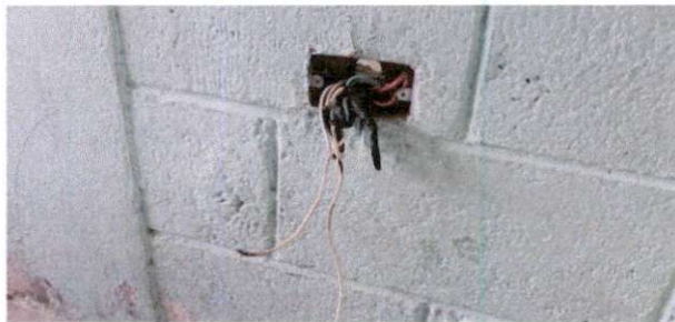
Foto 5: Sustitución de tomacorrientes dobles
