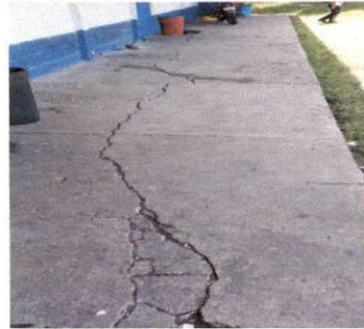
Foto 2: Sustitución de piso de torta de cemento
