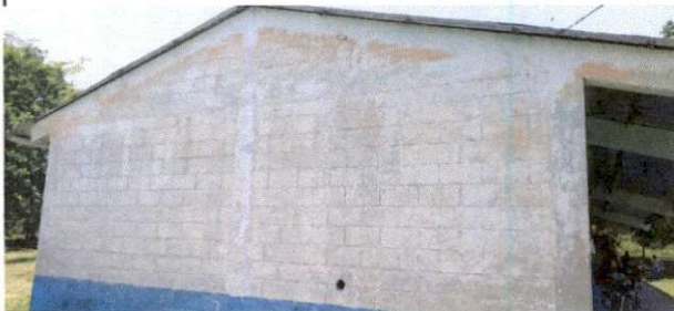
Foto 3: Pintura en muros exteriores e interiores
