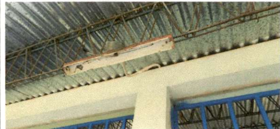
Foto 4: Reparación de cableado eléctrico
