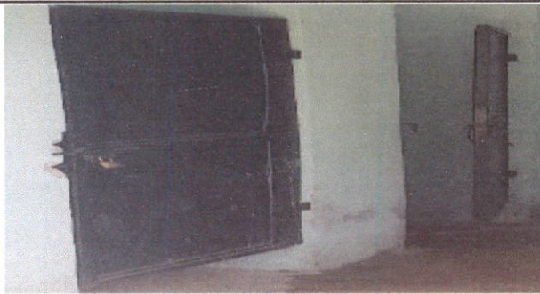
Foto 5: Sustitución de puerta.
