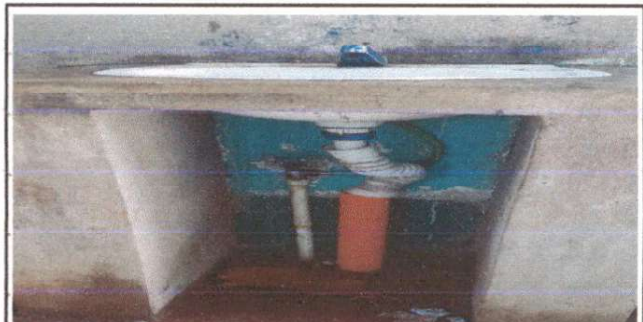
Foto 6: Sustitución de tubería PVC línea principal aguas negras,
