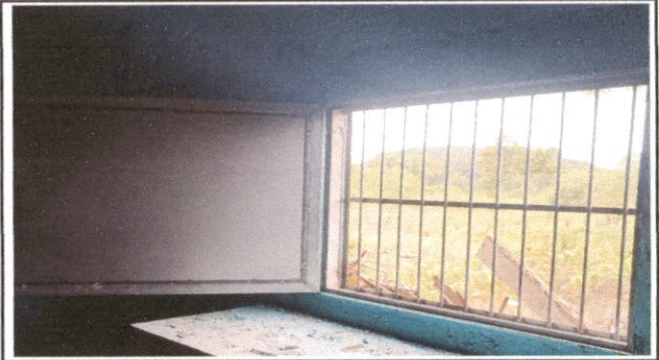
Foto 4: SUSTITUCION DE BALCON
