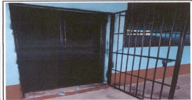
Foto 5: PINTURA EN PUERTAS DE AULAS
