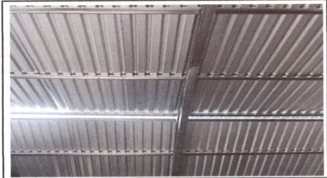
Foto1: INSTALACION DE ESTRUCTURA DE TECHO Y LAMINA POR LAMINA
