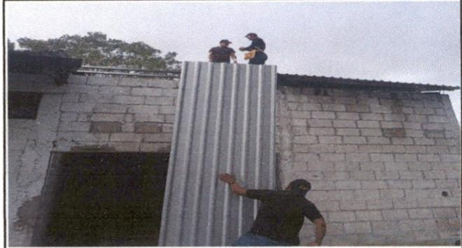
Foto 2: SUSTITUCION DE LAMINA POR LAMINA GALVANIZADA ALUZINC
