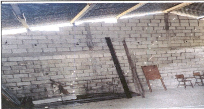
Foto1: SUSTITUCION DE ESTRUCTURA DE TECHO
