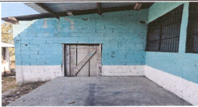
Foto 3: REPARACION DE PORTON
