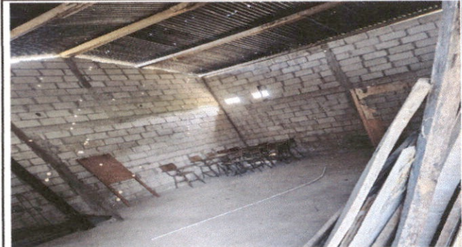
Foto 2: SUSTITUCION DE LAMINA POR LAMINA GALVANIZADA ALUZINC
