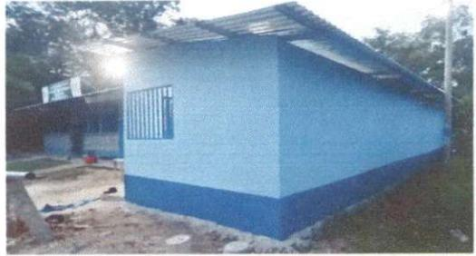
Foto 8: Repello en muro y pared
