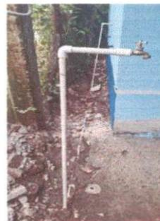
Foto 12: Sustitución de tubería línea principal con yave de paso y chorro
