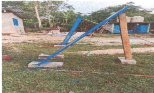
Foto 5: Sustrucción de puerta
