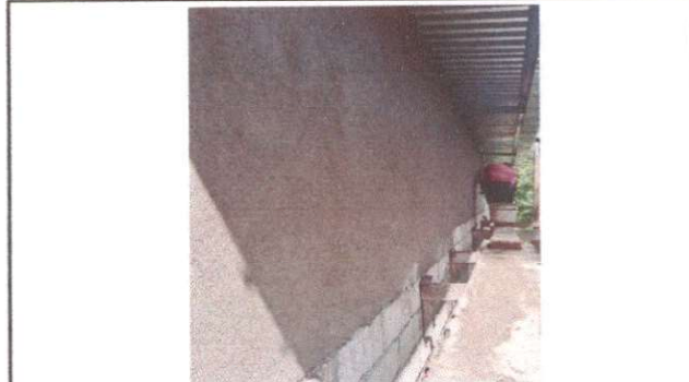
Foto 8: Repello en muro y pared
