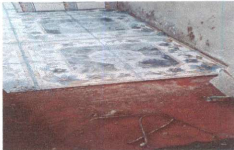
Foto 3: Sustrucción de piso cerámico
