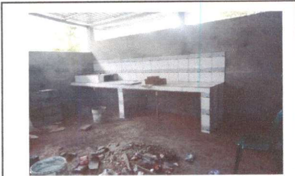
Foto 7: Instalación de azulejo en estufa rural
